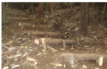
3日 里道に新たな階段設置
