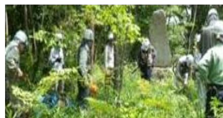
(20日) 雑草木生い茂る中の奮闘作業
