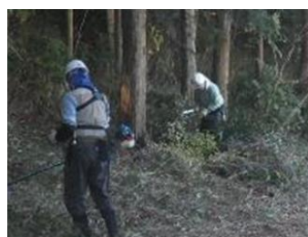
28日 通行障害木の伐木
