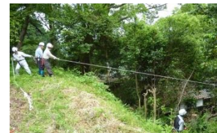
28日 ロープ掛けして伐倒
