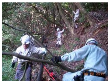
6日 回遊路1号線整備
