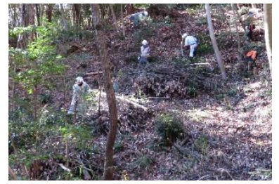
16日 枯損木・常緑樹の伐木除去
