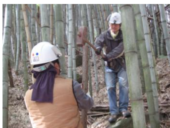
17日 棚積み用杭打ち
