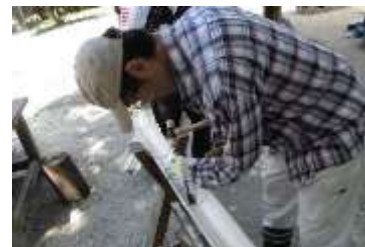
22日 竹樋の内面サンダー掛け
