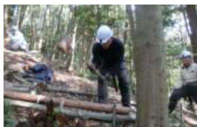
16日 作業道造り
