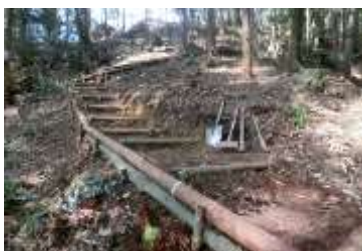
16日 完成した作業道
