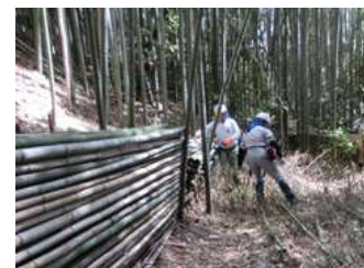
14日 風倒竹の伐採整理作業
